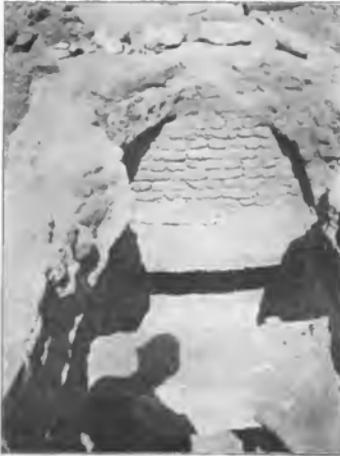
Abb. 2: Decke und Entlastungsgewölbe von Dyn. VI, 2.
